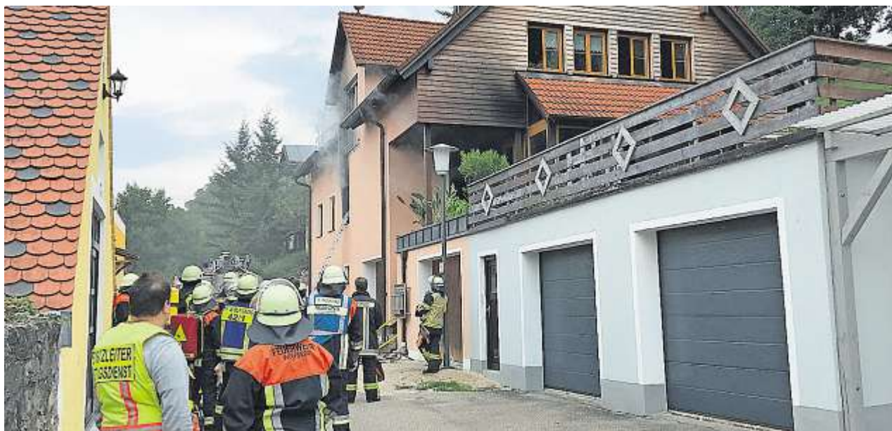
Das Obergeschoss des Hauses ist nun nicht mehr bewohnbar.
